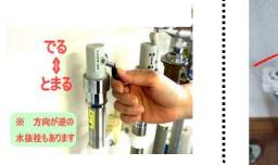
上下式レバーの場合は、<u>水抜レ</u> バーを上又は下にして水の止ま る方へ操作してください。
