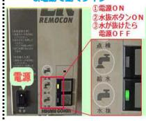
コンセントにプラグが差し 込まれているかを確認し、 電源スイッチをONにして 「水抜」ボタンを押してく ださい。全ての蛇口から水 が出なくなったら、電源を OFFにします。
