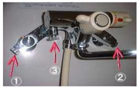
③シャワーヘッドはフックから外し浴槽内に 置いて、切替レバーを「シャワー」に合わせ ホース内の水を抜いてください。
