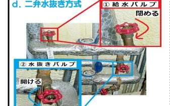
①給水バルブを右へ回し閉めてください。 (水を出す時は左に回し開けてください) ②水抜きバルブを左へ回し開けてください (水を出す時は右に回し閉めてください)
